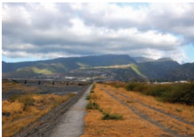
Digues de la rivière des Galets, Saint-Paul
