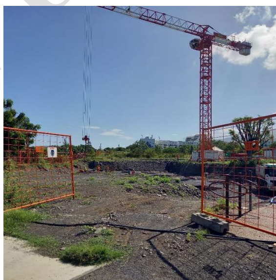
FIGURE 5 : NOUVELLE ECOLE D'ARCHITECTURE – EN COURS DE TRAVAUX (JANVIER 2026)
