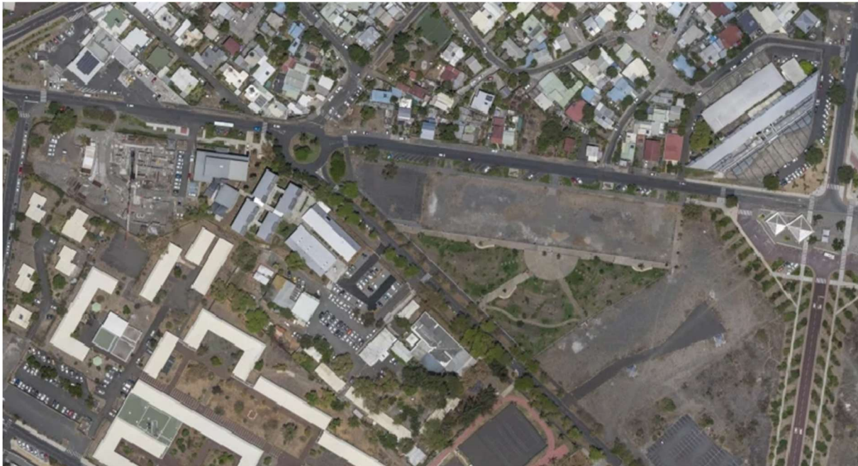
FIGURE 10 : VUE AERIENNE APRES TRAVAUX PHASE 1 - NOVEMBRE 2024
