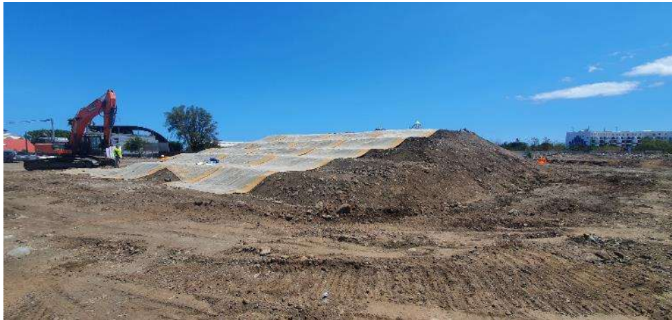
FIGURE 8 : MISE EN ŒUVRE DE LA GEOMEMBRANE BENTONITIQUE – EXTRAIT DOE DEPOLLUTION PICO
