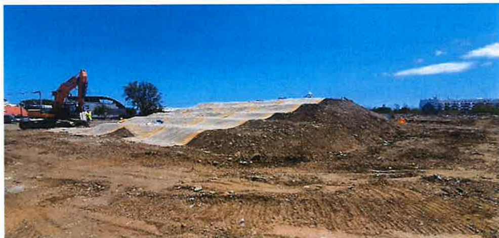
Figure 7: Mise en œuvre de la géomembrane bentonitique – extrait DOE dépollution PICO
