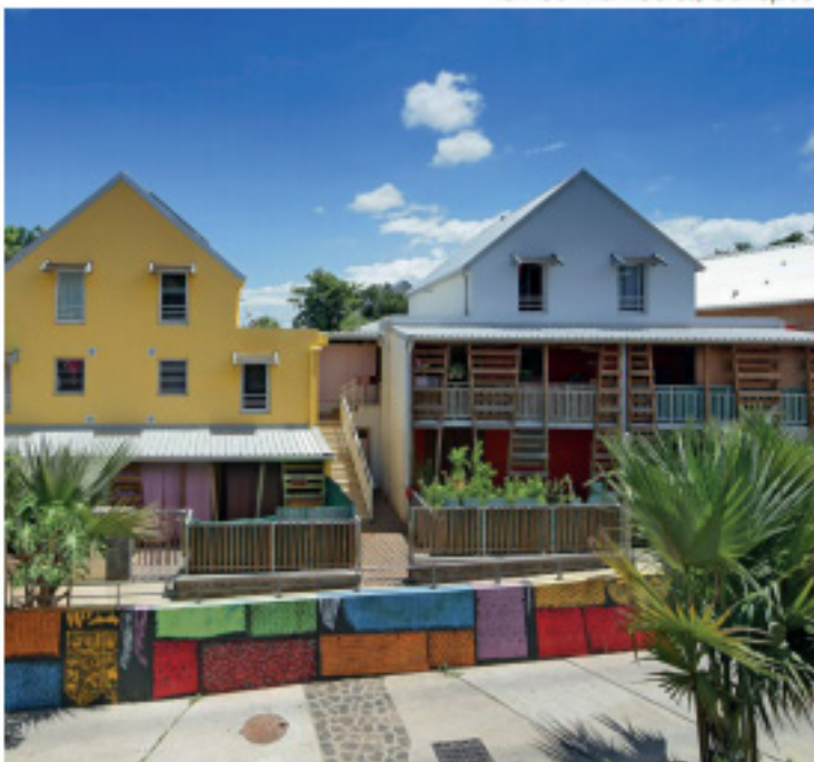
© Antoine Perrau Architectures, Le Lavoir
