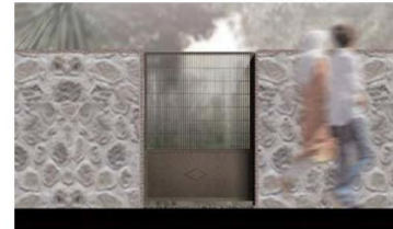
Portillon métallique partiellement ajouré en maille métallique. Description : Portillon en métal composé d'une ossature en profilé métallique, d'une partie pleine en tôle, d'une partie ajourée en maille métallique. Largeur 100-120 cm . Finition brute ou peinture. Prix indicatif : 200 Euros/U
